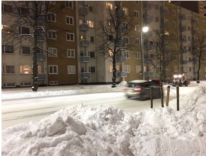
Kuva 16. Satakunnankatu 34-32 julkisivu parvekkeineen.
